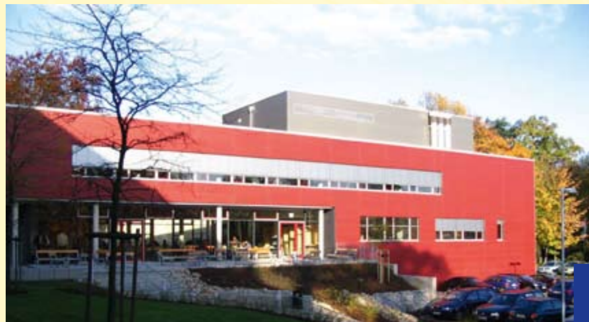
Abbildung 3: Mensa und Bibliotheksgebäude Haus G V
